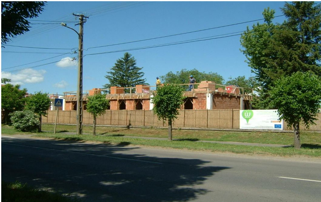
Az új bölcsőde építése – István király út 32.
